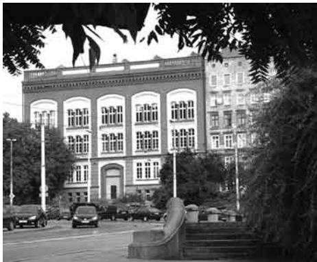
Fasada odnowionego gmachu Książnicy Pomorskiej
